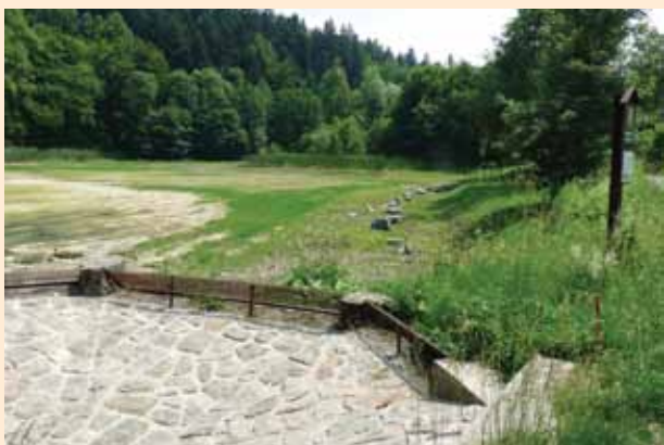
Bezpečnostní přeliv po rekonstrukci
