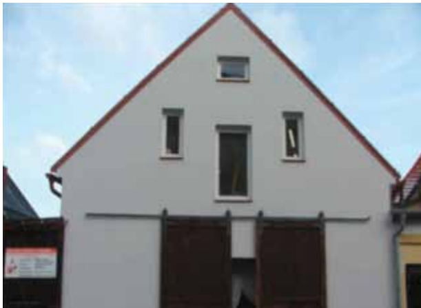
Objekt stodoly po rekonstrukci
