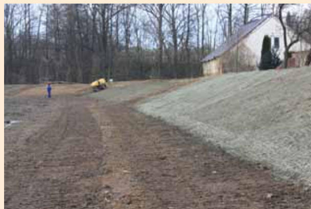
Jílové těsnění návodního líce hráze
