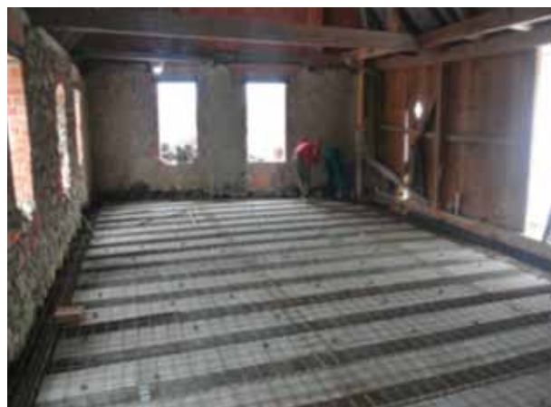
Velká technická budova – příprava nového stropu nad přízemím
