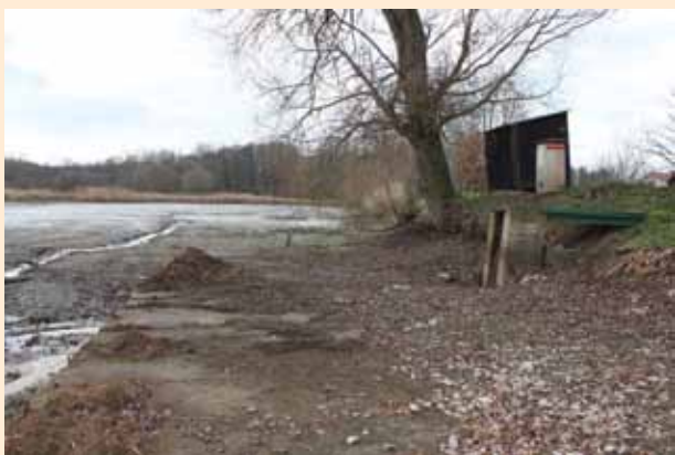
Stav hráze před rekonstrukcí
